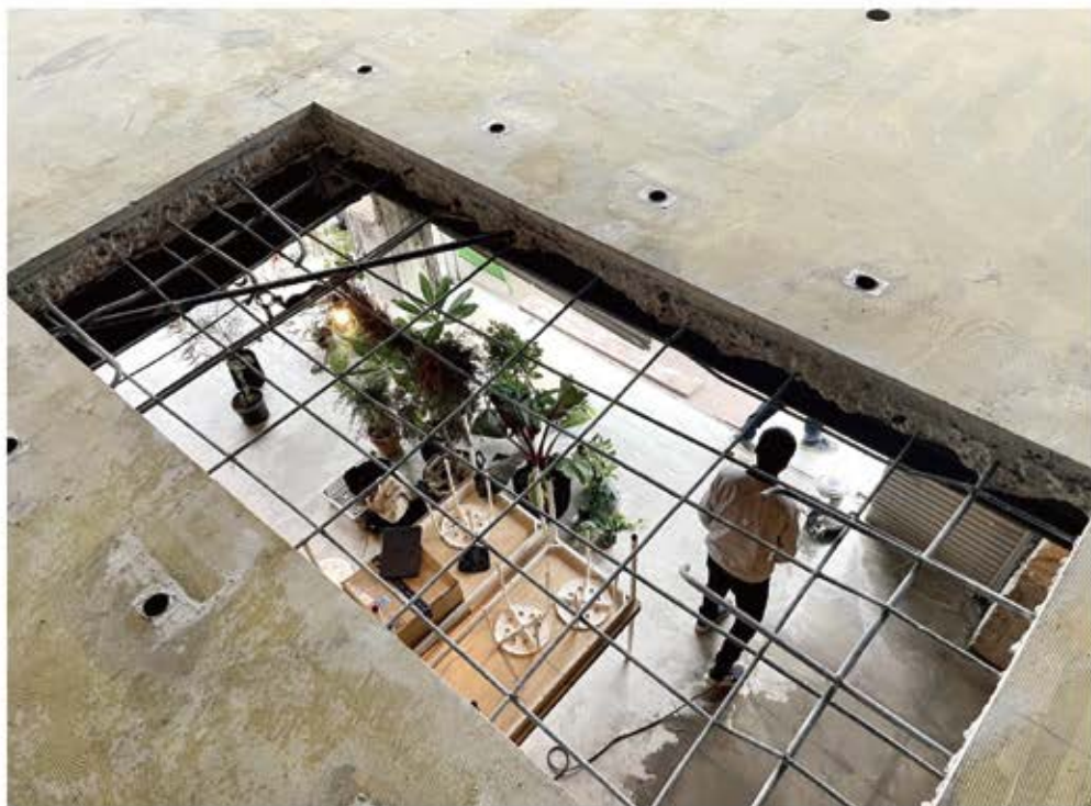
1期分解工事の終了間際
