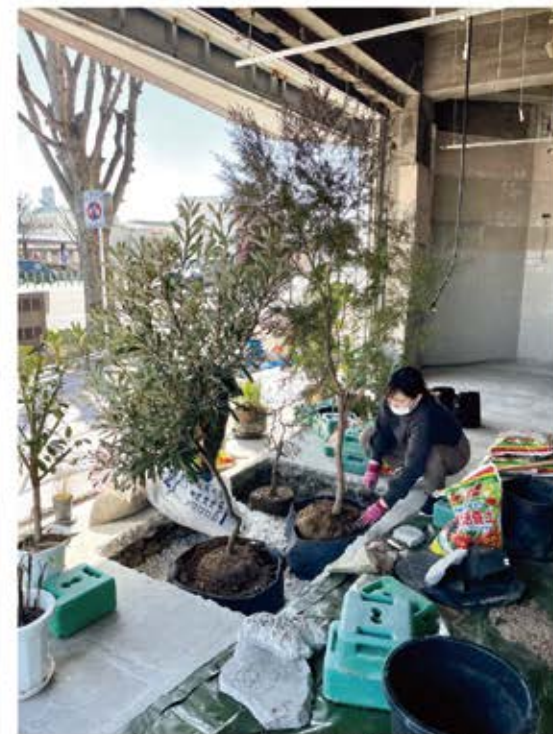
2期分解工事途中の外構工事
